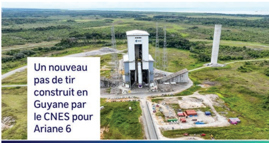
Figure 5 : Nouvel ensemble de lancement Ariane 6 au CSG.
