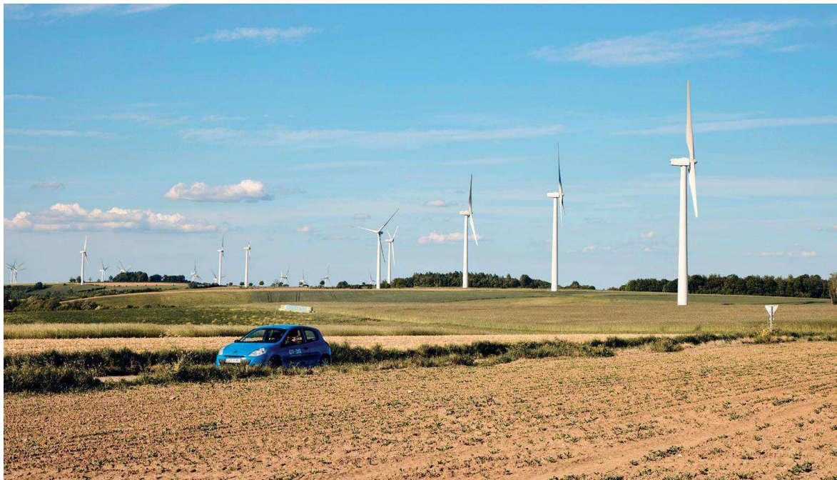
Figure 2 : Environ 90 % des installations éoliennes et photovoltaïques sont raccordées au réseau de distribution (Source : Enedis).
