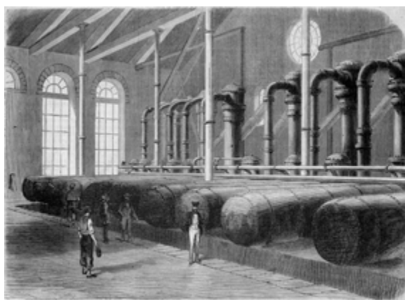
Fig. 16. Les compresseurs destinés à alimenter en air comprimé les perforatrices mises au point par Sommeiller, Grandis et Grattoni ( L'illustration , février 1862). Ces énormes installations étaient en cours de montage lorsque les membres de la Société géologique de France visitèrent des ateliers situés aux Fourneaux, le 5 septembre 1861.
