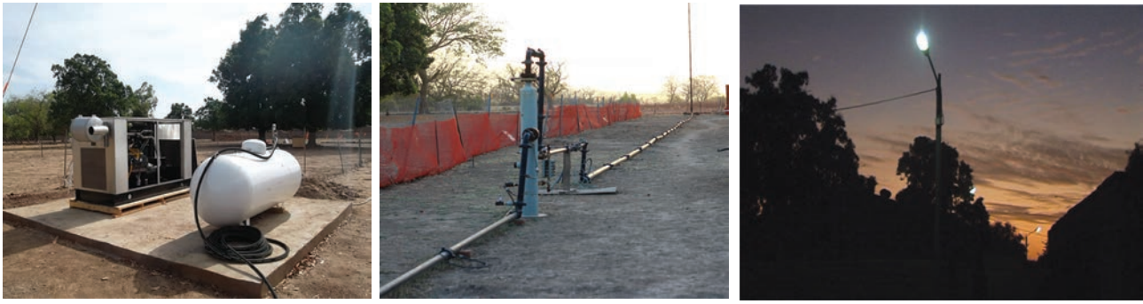
Figure 6 : Unité pilote de production d'électricité installée à Bourakebougou – Source : photo©Hydroma.
