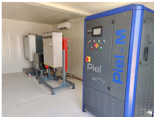
Photos 2 et 3 : Local d'installation de l'électrolyseur utilisé dans le cadre du projet Power-to-X \mu Pilot et photographie de cet équipement.
