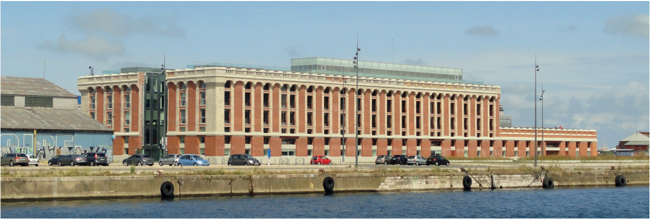
Figure 5 : La Halle aux Sucres – Môle 1.
