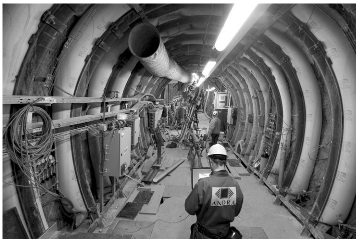
Galerie d'expérimentation dans le laboratoire souterrain de Meuse/Haute-Marne, à - 490 m.
