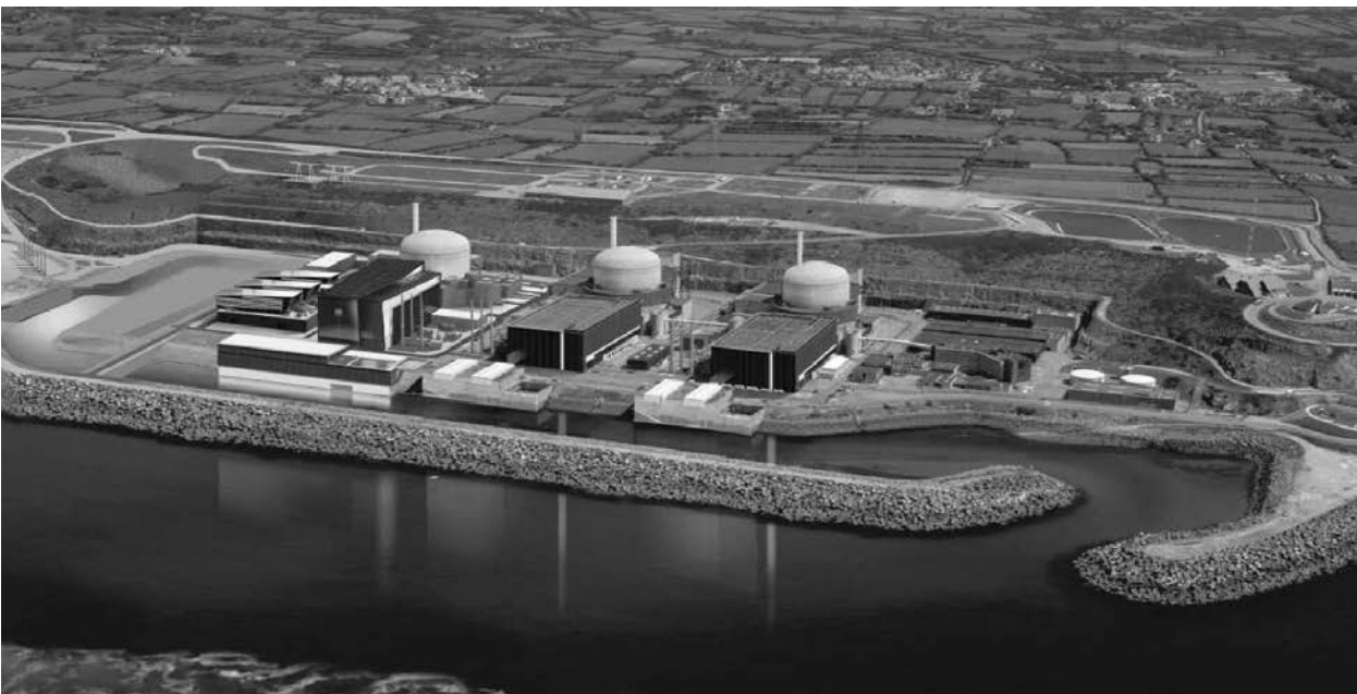
Le site de Flamanville en 2012 : à gauche la « tête de série » EPR ; à droite les deux tranches de 1 300 MWe (image de synthèse).
