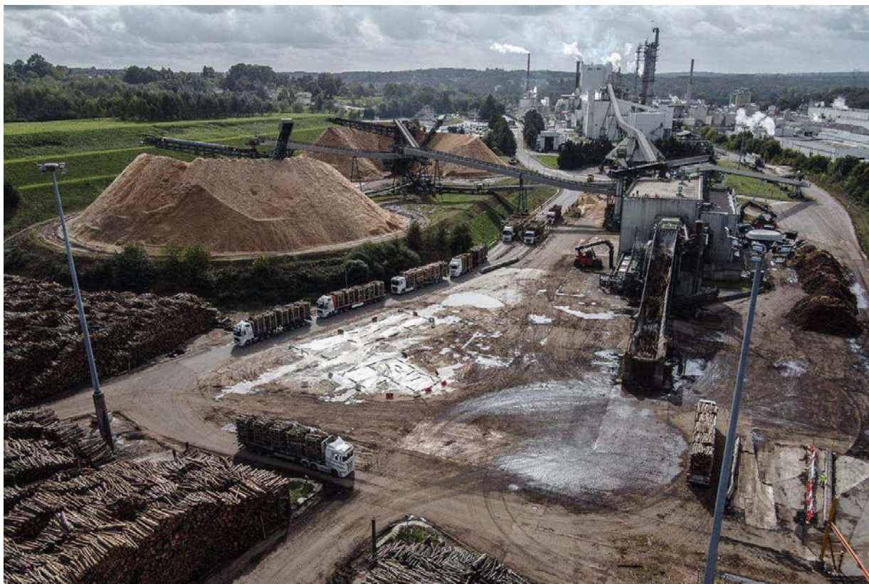
Photo 2 : Vue aérienne d'une usine de production de pâte de cellulose. On peut noter au premier plan le parc à bois et l'atelier de mise en plaquettes (Crédits photos : Copacel).
