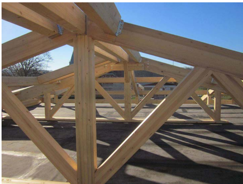
Figure 7 : Bâtiment ONF - Chambre d'Agriculture d'Épinal. Charpente constituée de sapin sain (lamellé collé) et d'épicéa scolyté (poutres) sans altération mécanique du bois (crédit photo : Denis Dagneaux, ONF Grand Est).
