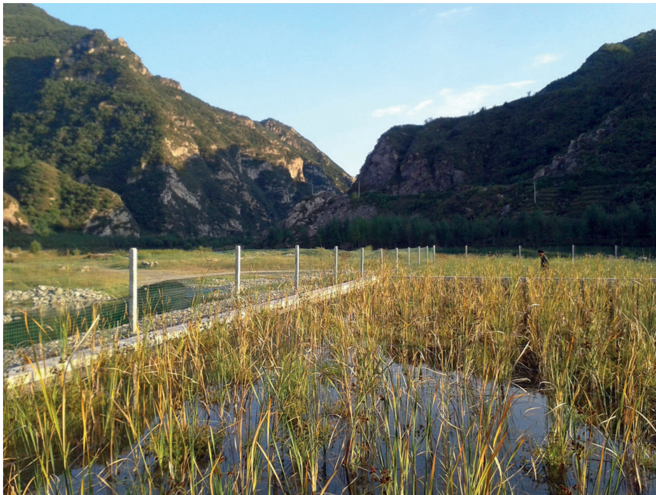
Filtres plantés de roseaux en dérivation du lit principal d'une rivière, en Chine.
