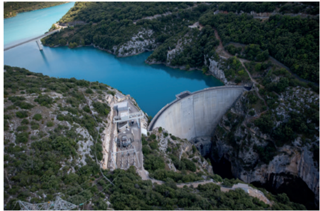
Le barrage de Sainte-Croix (Région Provence-Alpes-Côte d'Azur).
