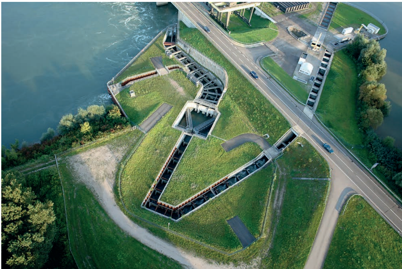
Passe à poissons aménagée en bordure d'un barrage.
