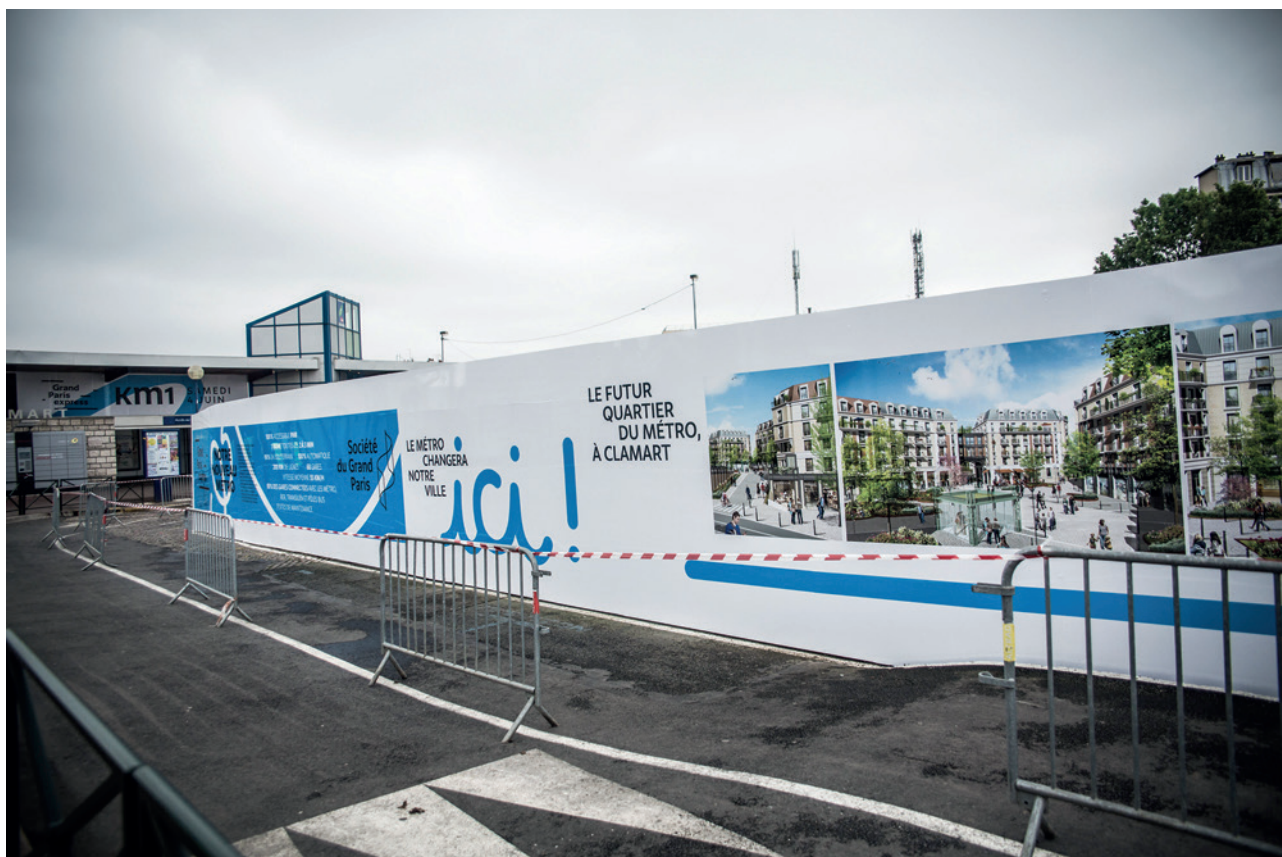
Le chantier du futur quartier du métro à Clamart s'inscrivant dans le cadre des travaux du Grand Paris Express.
