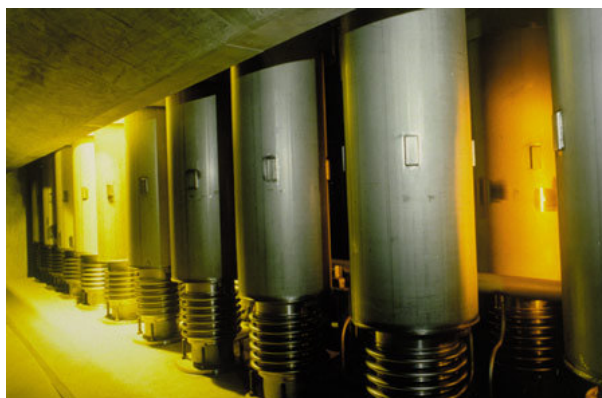
Puits dans la casemate en béton sur le site Cogema d'entreposage de colis de verres à La Hague
