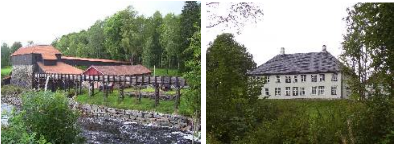
Fig. 5. De voormalige hoogoven van Nes Jernverk na restauratie (2008) en het prominente woongebouw.
