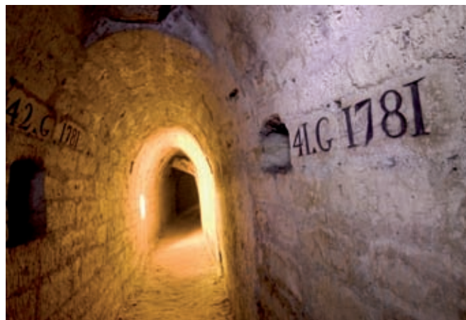
Galerie réalisée en 1781 sous l'hôpital Cochin, du temps de l'Inspectorat de Charles-Axel Guillaumot, d'où l'initiale "G" (ici les travaux numérotés 41 et 42).
