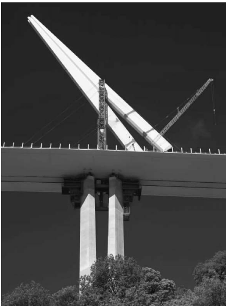
Figure 5 – Le pylône est mis debout.
