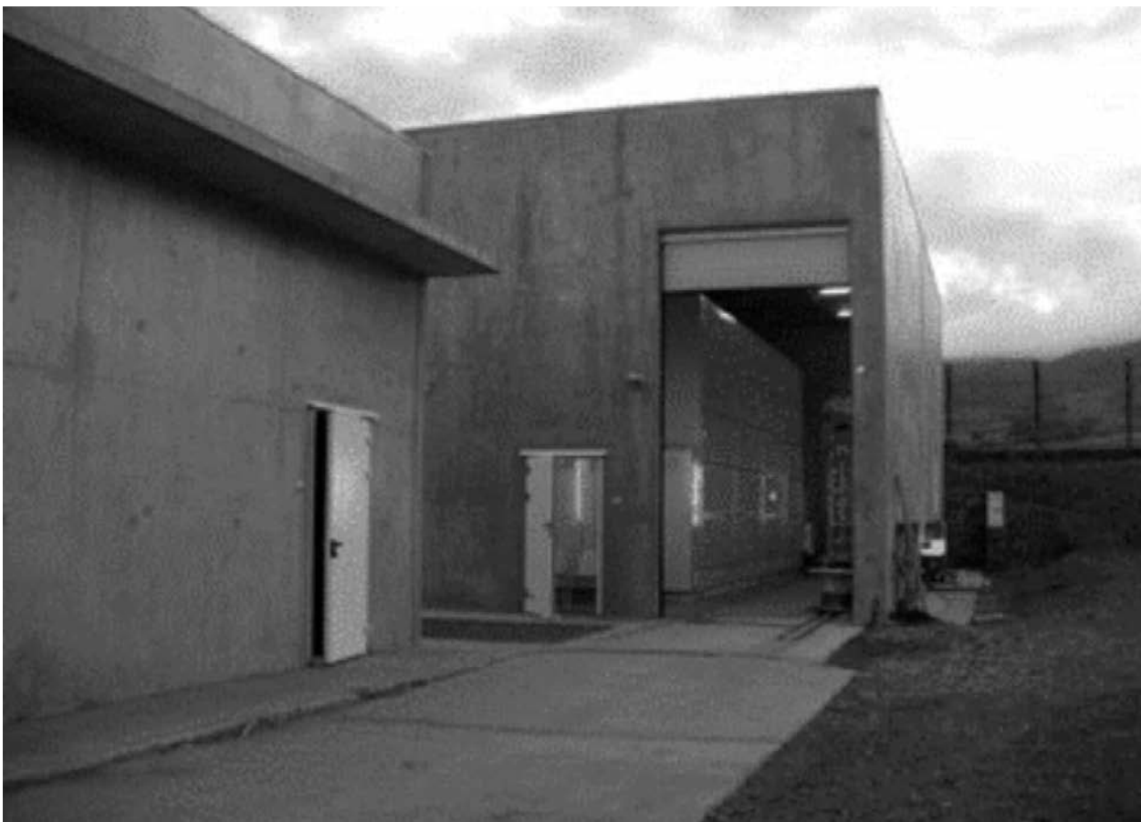
Photo 2 : Site de stockage d'électricité au moyen de batteries.
