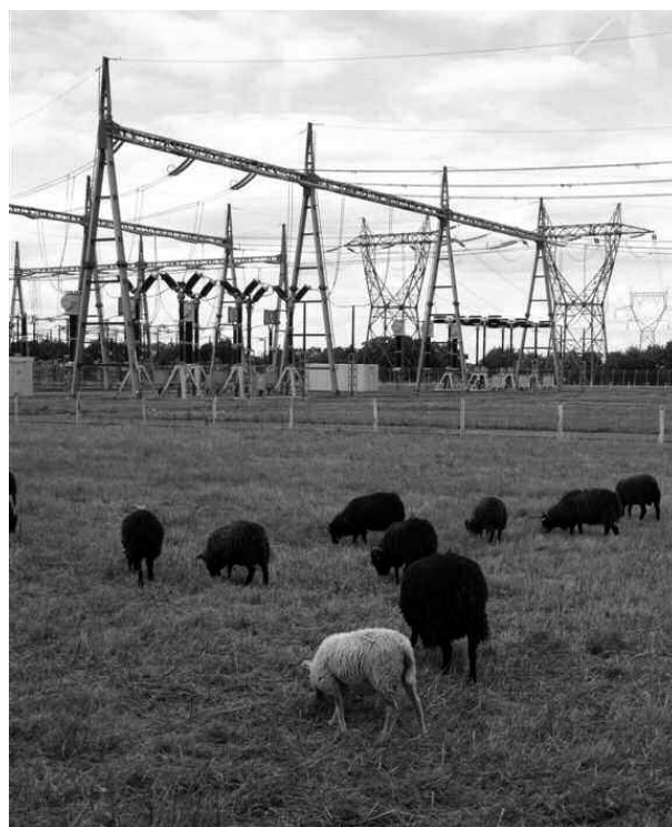
Entretien du poste électrique de Louisfert, en Loire Atlantique, par des moutons d'Ouessant.
