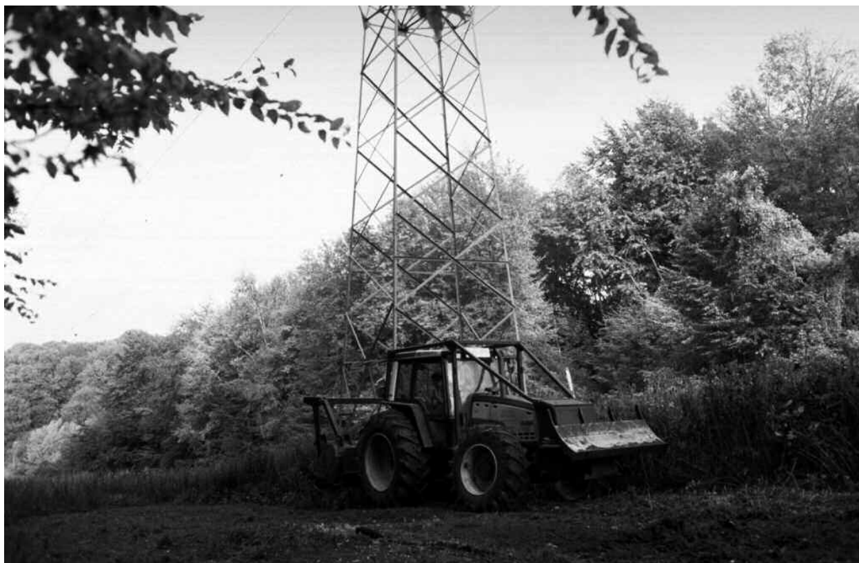
Entretien d'une tranchée forestière avec un gyrobroyeur.
