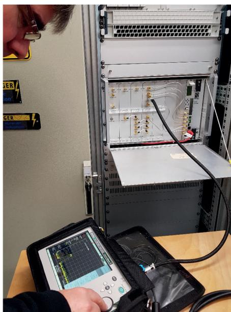
Mesures spectrales pour le traitement d'un brouillage.
