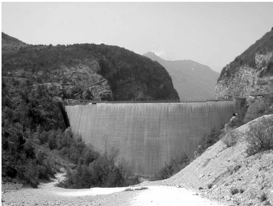
Fig. 12. Le barrage de Vajont vu d'amont : le terrain glissé ne laisse voir que la partie supérieure, la route de crête a été emportée ; la trace de la vague en rive gauche est rendue visible par l'absence de végétation sur 100 m plus haut (photo de l'auteur, mai 2003).
