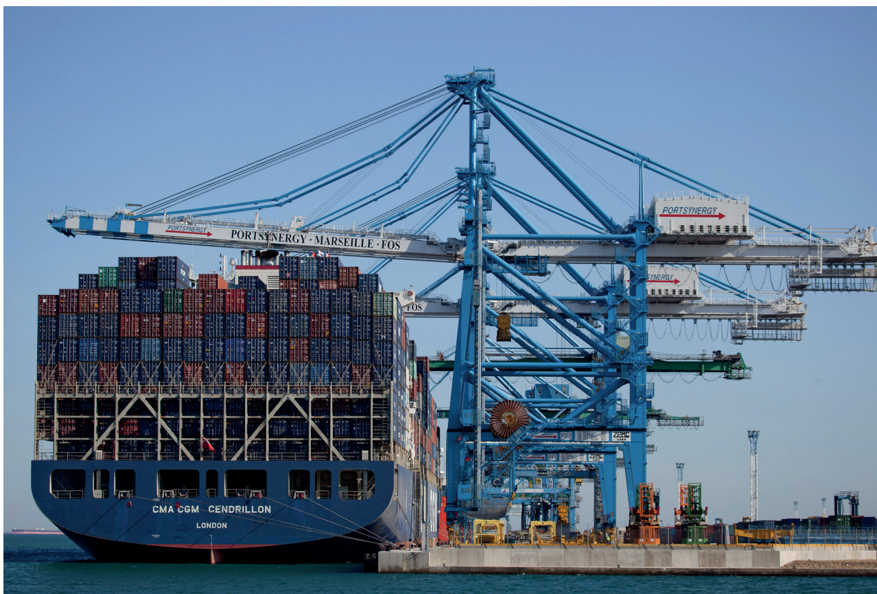
Grand port maritime de Marseille : le terminal conteneurs Fos 2XL, Fos-sur-Mer, septembre 2011.
