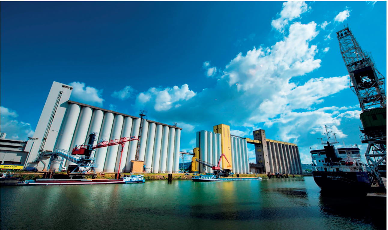
Poste de déchargement (par aspiration) des péniches à la Presqu'île d'Elie au cœur du port de Rouen.
