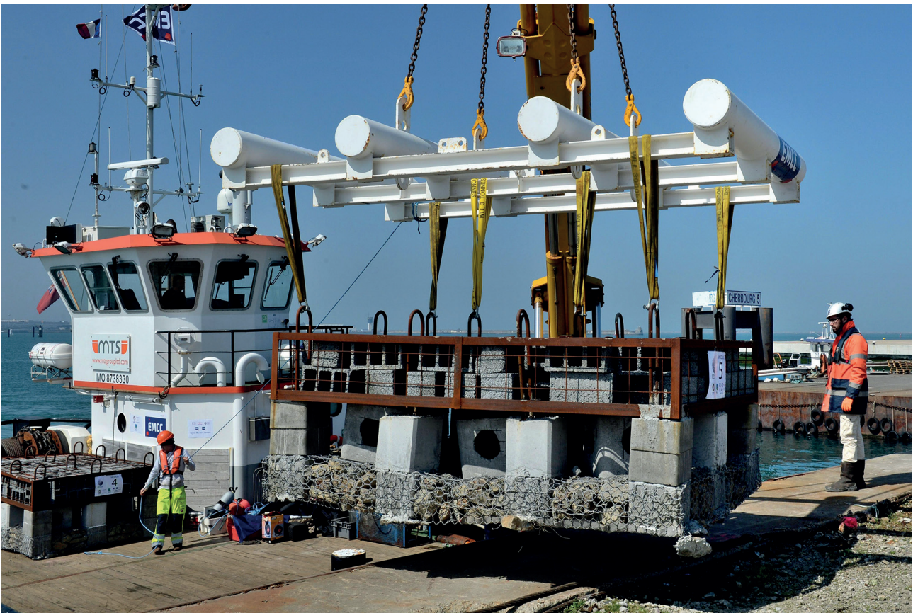
Chargement de récifs artificiels destinés à être immergés dans le cadre du programme européen de coopération transfrontalière France-Angleterre, Cherbourg, avril 2015.
