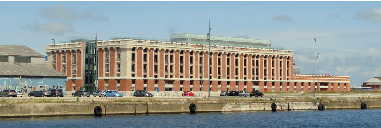
Figure 5 : La Halle aux Sucres – Môle 1.
