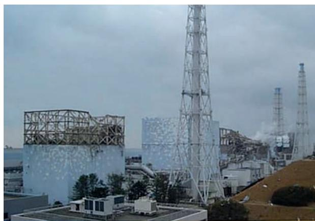
Figure 3 : Les superstructures des réacteurs de la centrale de Fukushima Daiichi détruites par les explosions (source : photo©TEPCO (médiathèque IRSN)).
