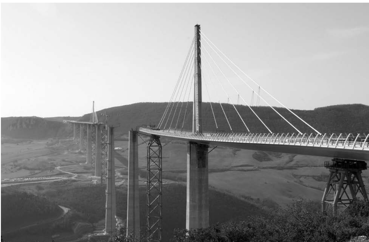
Chantier du viaduc de Milhau, construction du tablier et des haubans (mars 2004)
