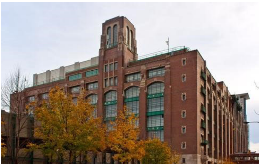
Chicago, Lakeside Technology Center (le plus grand data center des États-Unis), vers 2014 (Source : Networkcomputing.com )
